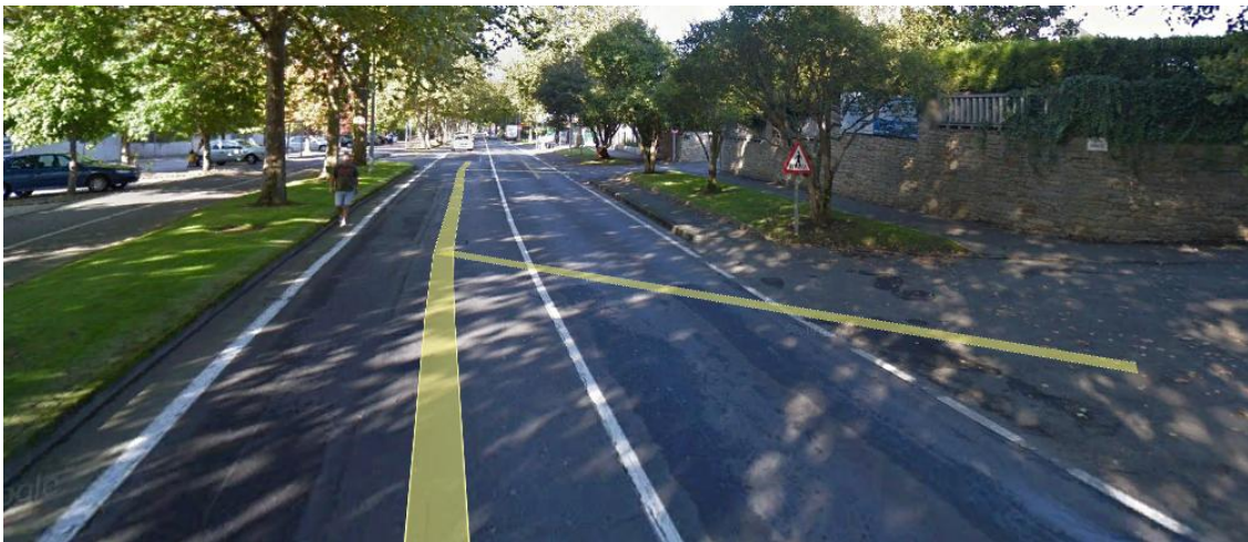
Avenida Che Guevara: prohibida la circulación por arcenes. Permitida la circulación por aceras.
